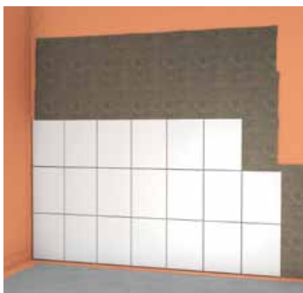
Obrázek 6: Keramický obklad do tenkého lože z flexibilního lepidla fermacell s celoplošnou aplikací těsnícího systému (platí pro třídu zatížení vlhkostí A, viz. tabulka str. 32).
