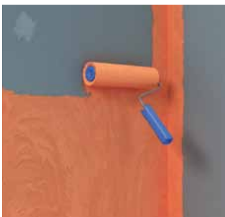
Obrázek 5: Tekutá fólie fermacell se nanáší celoplošně válečkem ve dvou vrstvách (celková tloušťka \geq 0,5 mm), doba schnutí: min. 2-3 hodiny
