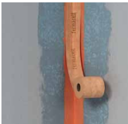
Obrázek 2: Těsnící páska fermacell se vtlačí do nanesené ještě vlhké tekuté fólie fermacell a ihned se tekutou fólií přetře, doba schnutí: min. 1 hodina
