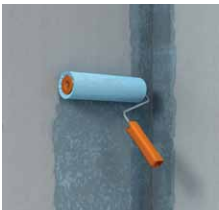
Obrázek 1: Celoplošný nátěr hloubkovou penetrací fermacell , doba schnutí: min. 2 hodiny
