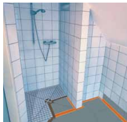
Obrázek 7: Podlahové plochy jakož i bezbariérové sprchy je možno realizovat podlahovým prvkem fermacell Powerpanel TE. Přesné informace najdete v prospektu „Podlahové systémy fermacell – plánování a zpracování“
