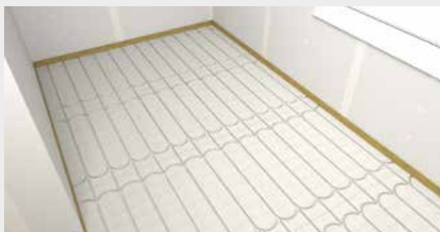
Pokládka prvků fermacell® Therm25.
