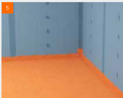
5 Celoplošné utěsnění povrchu v oblasti W1-I.
