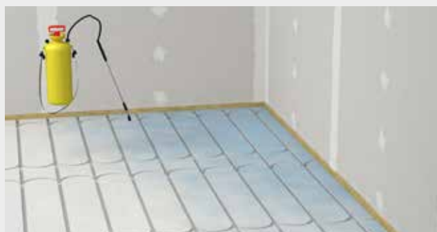
Aplikace hloubkové penetrace fermacell® na fermacell® Therm25.
