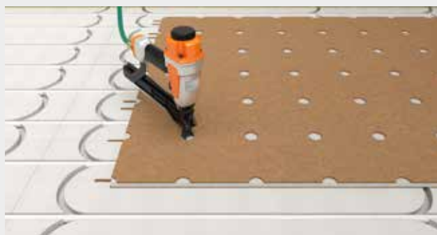
Montáž krycí desky a mechanické upevnění pomocí šroubů nebo sponek s použitím šablony.
