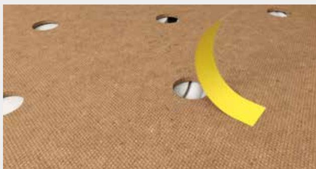
Umístěte šablonu na sádrovláknitě desky fermacell® jako krycí desku. Zkontrolujte, zda se pod otvorem nachází topné trubky. Pokud ano, zakryjte upevňovací bod lepicí páskou.
