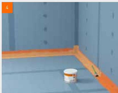
4 Těsnící pásku přetřete tekutou fólií fermacell™ ihned po přitlačení.
