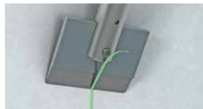
Odstraňte přebytečné lepidlo pomocí Škrabky na lepidlo fermacell™
