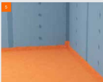
5 Celoplošné utěsnění povrchu v oblasti W1-I.
