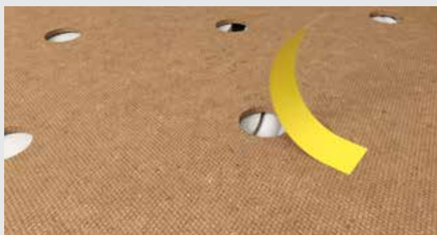
Umístěte šablonu na sádrovláknitě desky fermacell® jako krycí desku. Zkontrolujte, zda se pod otvorem nachází topné trubky. Pokud ano, zaslepte upevňovací bod lepicí páskou.
