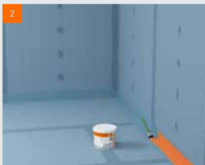
2 V rohu použijte tekutou fólii fermacell™.
