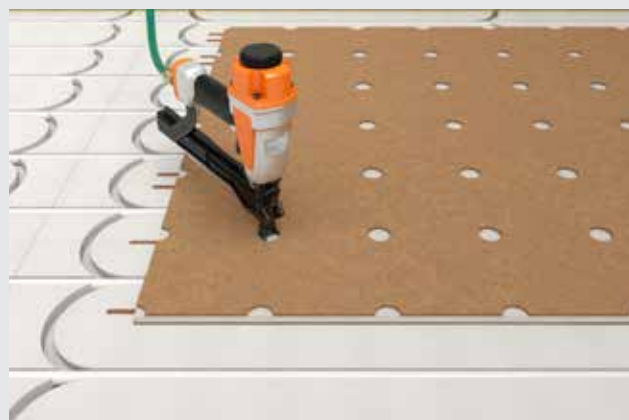
Montáž krycí desky a mechanické upevnění pomocí šroubů nebo sponek s použitím šablony.
