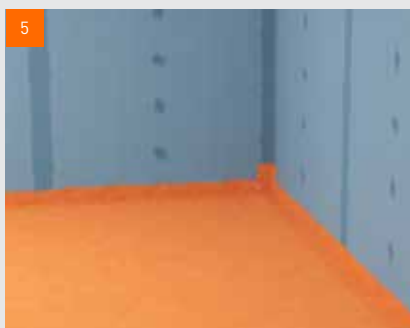
5 Celoplošné utěsnění povrchu v oblasti W1-I.
