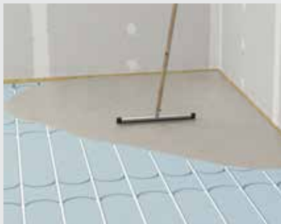
Zalítí prvků Therm25™ sádrovou lepicí maltou fermacell™
