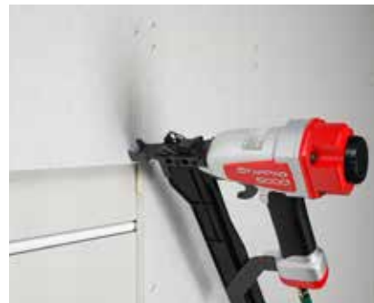
Přídavná vrstva sádrovláknité desky fermacell® nebo Powerpanel H 2 O včetně vytvoření spár
