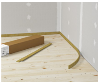
❶ Instalace okrajové izolační pásky se spojením v rozích na tupo.
