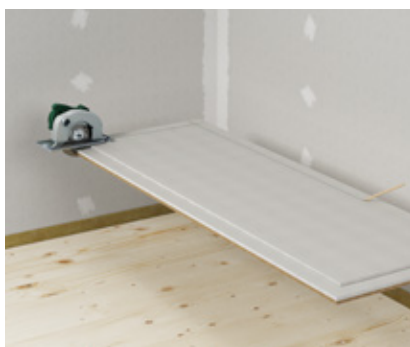
❷ Odříznutí přesahující polodrážky pro první řadu pokládky.
