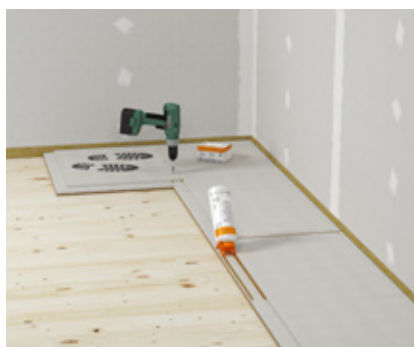
❹ Do polodrážky naneste podlahové lepidlo fermacell™.
