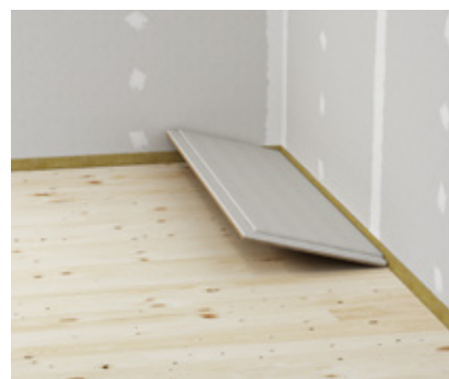
❸ Pokládka podlahových prvků fermacell®.
