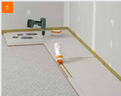
Spojování jednotlivých podlahových prvků fermacell®
