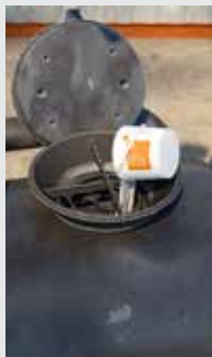
Míchání: 6 pytlů voštinového zásypu fermacell™ + 1 kbelík kameninového pojiva fermacell™
