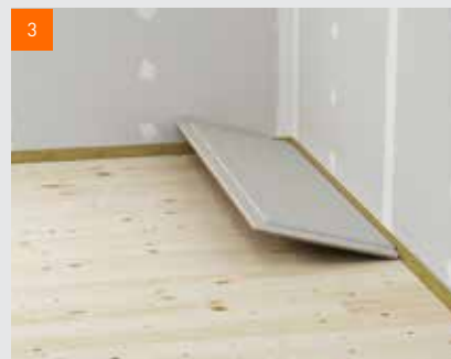
3 Založení prvního podlahového prvku fermacell®
