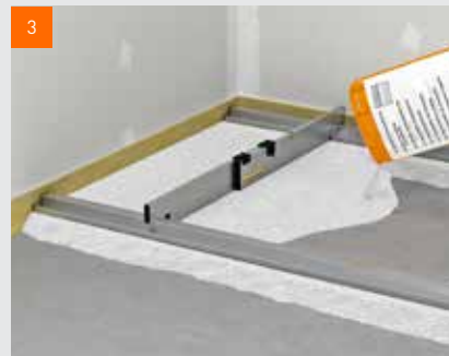
Aplikace vyrovnávacího podsypu
