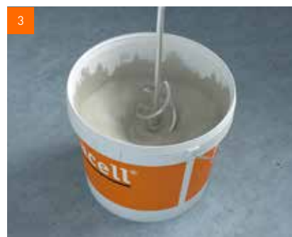
Promíchání vhodným míchadlem při nízkých otáčkách až vznikne homogení, bezhrudková samonivelační hmota
