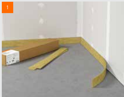
Upevnění okrajových izolačních pásek
