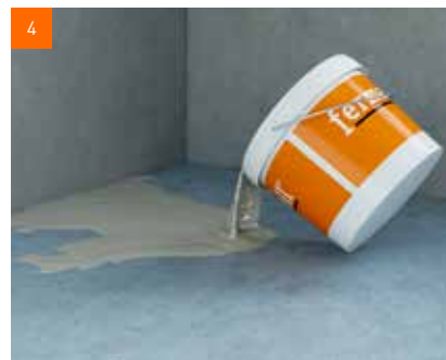
Nivelační hmotu vylijte a vyrovnejte
