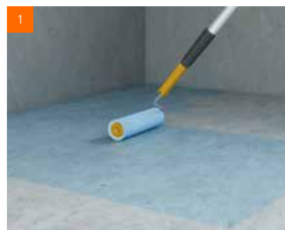
Příprava: penetrace podlahy
