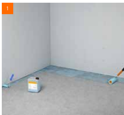
Příprava podkladu hloubkovou penetrací fermacell™
