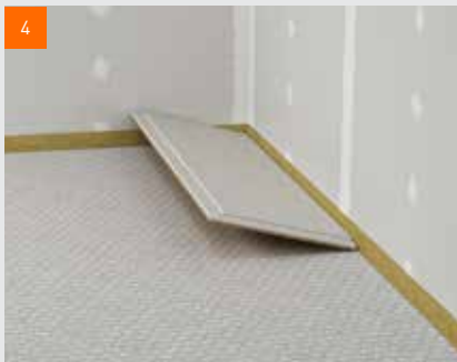
Pokládka podlahových prvků fermacell®
