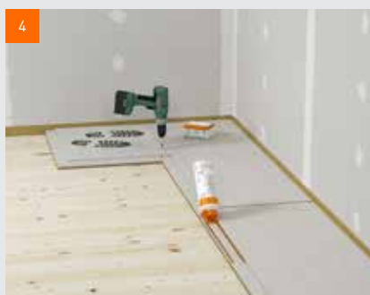
4 Nanášení podlahového lepidla fermacell™ na polodrážky
