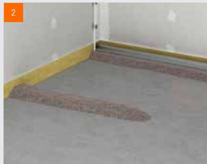
Násyp akustického podsypu fermacell™
