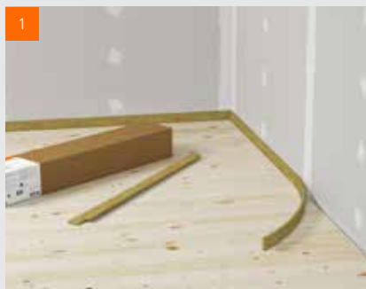
1 Položte okrajové izolační pásky a v rozích sraďte na tupu
