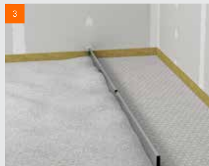
Zarovnání voštinového zásypu fermacell™
