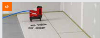
6a 6b Fixace pomocí šroubů nebo speciálních rozpěrných sponek... vše do deseti minut po nanesení lepidla
