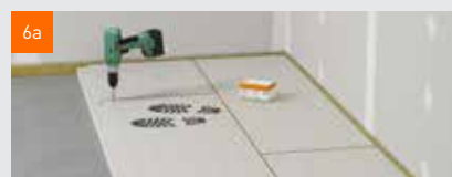
3 Založení prvního podlahového prvku fermacell®
