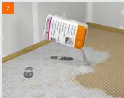
Vyplnění voštiny voštinovým zásypem fermacell™
