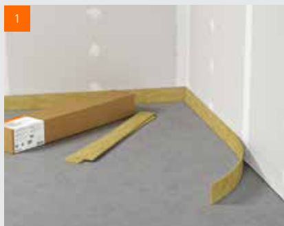
Upevnění okrajových izolačních pásek
