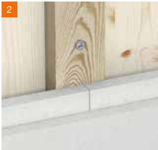
2 Opláštění na dřevěné nosné konstrukci (vodorovná/svislá)
