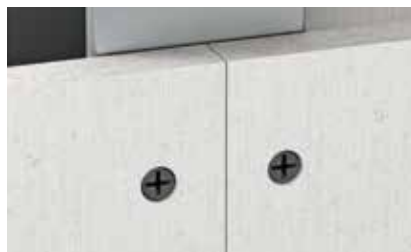
Těsné napojení desek – šířka spáry: \leq 1 mm
