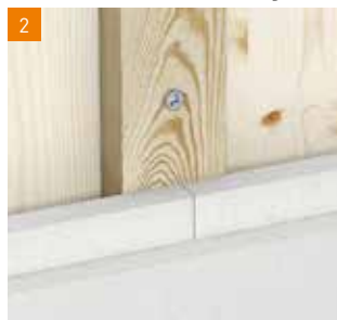
2 Opláštění na dřevěné nosné konstrukci (vodorovná/svislá)
