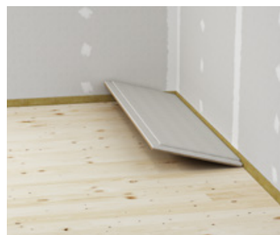
3 Pokládka podlahových prvků fermacell®.
