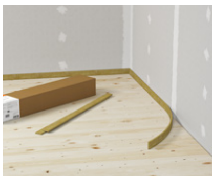
1 Instalace okrajové izolační pásky se spojením v rozích na tupo.
